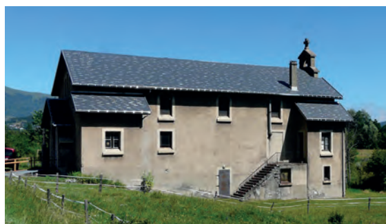
Nouvelle toiture sur Notre-Dame des Neiges.
