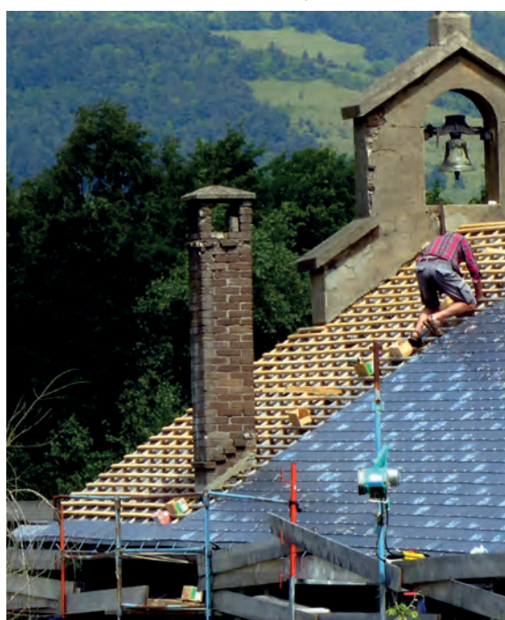
Réfection de la toiture.
